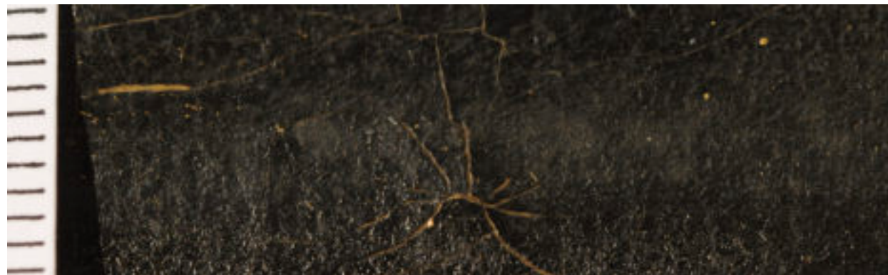
Nach der Abnahme der Ansammlung von Staub und Schimmel
