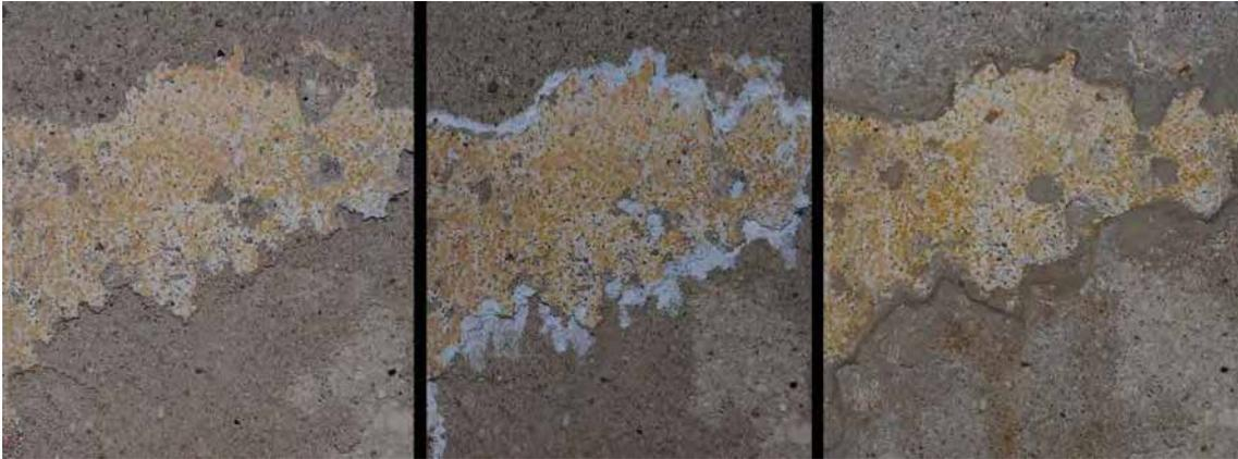
Abb. 33, 34, 35: Leuben, Schloss, Raum 012, Ostwand, Bereich Musterkonservierung: Behandlung abgelöster Malschicht, Detail vor (links), während (Mitte) und nach (rechts) der Behandlung
