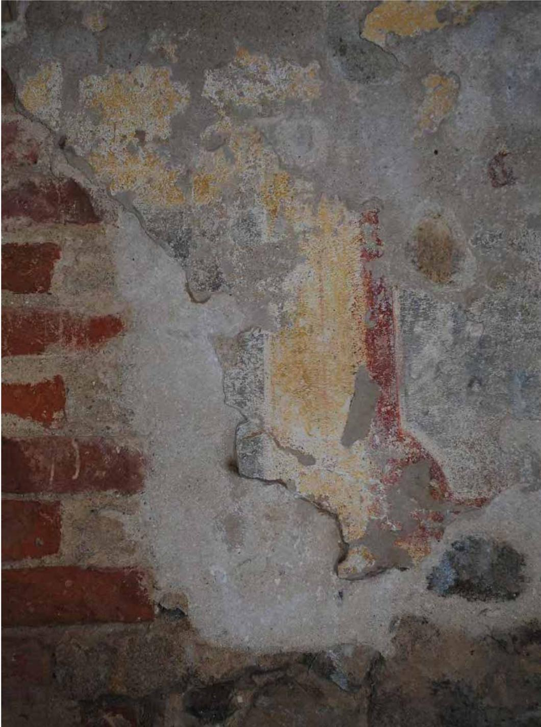
Abb.36: Schloss Leuben, Raum 012, Ostwand, mittlerer Wandbereich, Sockelzone: Musterfläche nach der Beendigung der Konservierungsmaßnahmen
