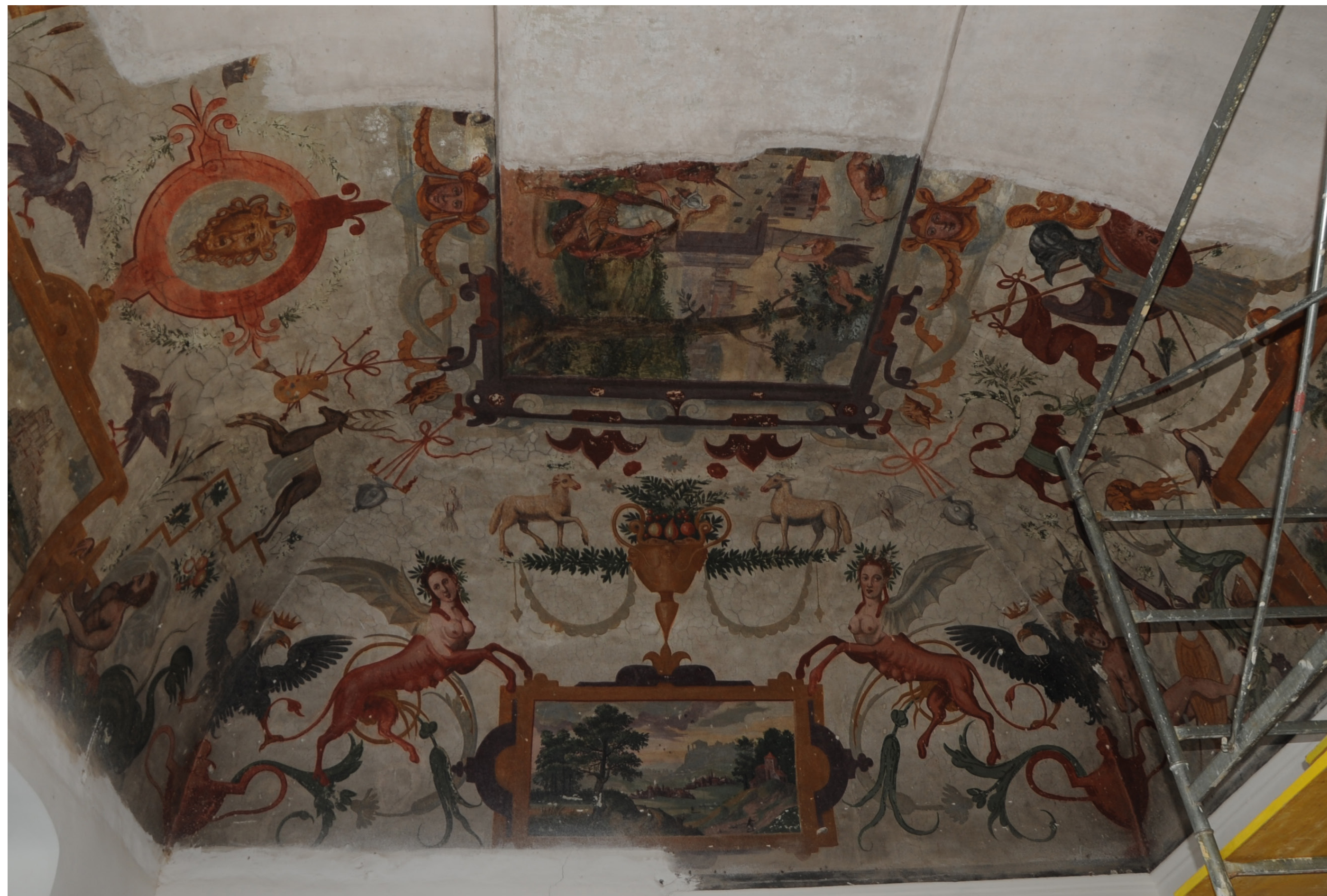
Blick von Westen in das Gewölbe von Raum 1-2
