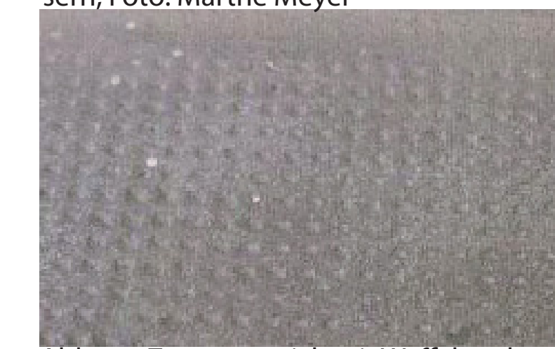
Abb. 14: Zementestrich mit Waffelstruktur, Foto: Winfried Brenne
