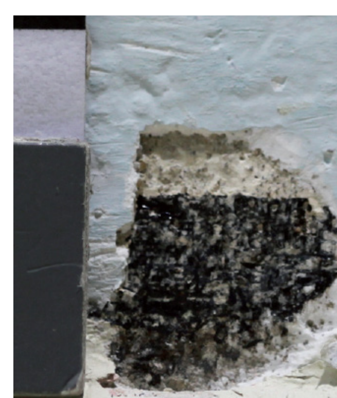
Abb. 3: schwarzer Streifen (in Teer) und hellgelb, bräunliche Wandfarbe, oberhalb der Fußleisten in den Wohnräumen, Foto: Marthe Meyer
