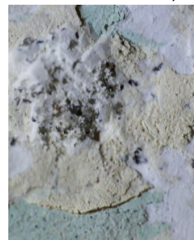
Abb. 6: Hellgelb, bräunlicher Leimfarben- Wand-/Deckenanstrich der Wohnräume (Kinderzimmer, Elternschlafzimmer und Wohnzimmer) Foto: Marthe Meyer
