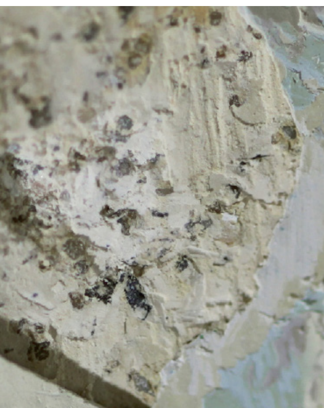
Abb. 8: Hellgelb, bräunlicher Kalkfarben- Deckenanstrich der Wirtschaftsräume (Flur, Bad, Küche) Foto: Marthe Meyer
