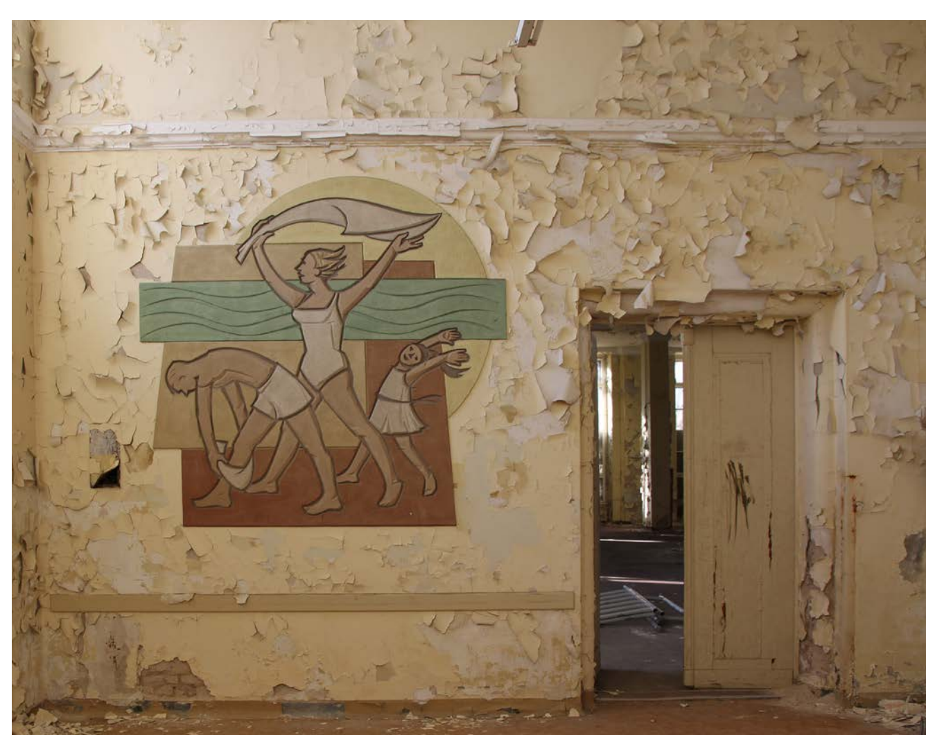
Übersicht der Süd-West-Wand mit dem Putzschnitt „Bewegung“.
