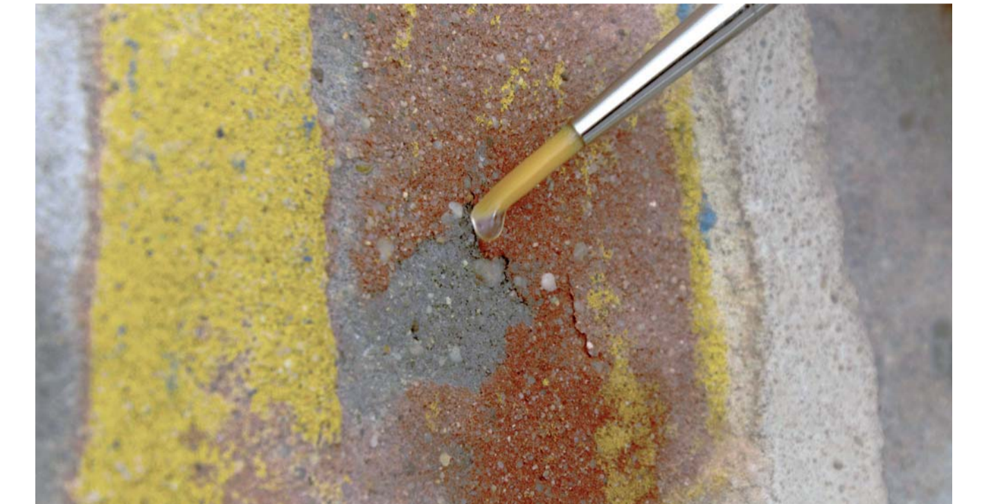
Kontrollierter Eintrag des Festigungsmittels mit einem Pinsel. Je nach Anforderungen standen folgende Lösungen zur Wahl: Tylose® MH 300 0,5 vgggg% in Wasser und Ethanol (1:1) oder Ludox® PX 30 0,2% in Wasser.
