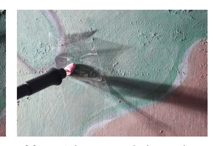
Abb. 17 Schritt 4: Niederlegen der Schollen mit kleinem Heizspachtel
