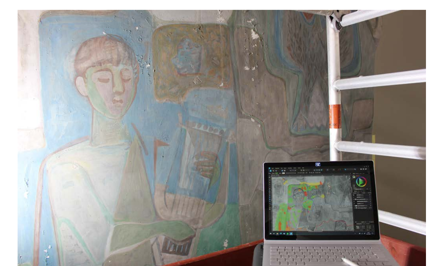
Abb. 20 Erstellung der digitalen Zustandskartierung
