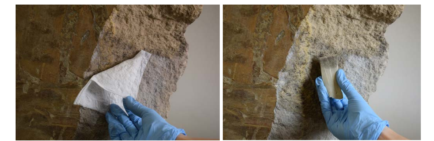
Abnahme der festen Verschmutzungen mit feuchten Zellstoffkompressen und Schwämmen.
