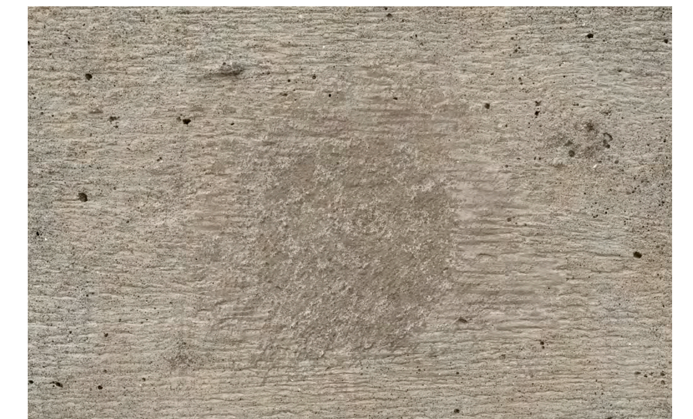
Farblich integrierte spätere Kittung eines Schalungsankers. Zunächst wird durch einen lasierenden Farbauftrag der Grundfarbton der Kittung an die Umgebung angepasst. Durch einen tüpfelnden Farbauftrag wird die Form und Farbe der bauzeitlichen Kittungen imitiert. Zur Imitation der Holzmaerung werden horizontale Striche verwendet.
