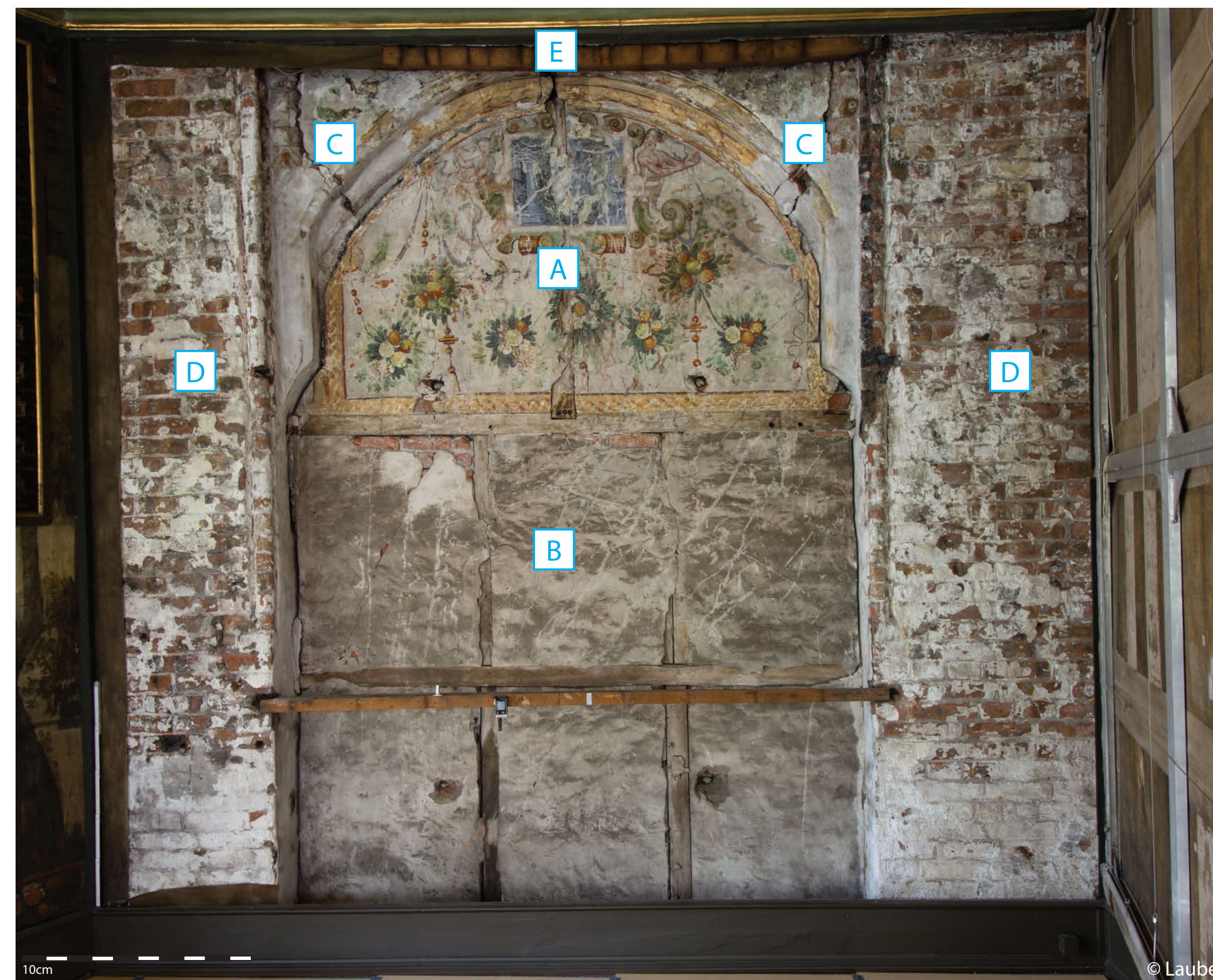
Abb. 2: Gesamtaufnahme der Südwand. Am rechten Bildrand ist der Aluminiumrahmen sowie die Rückseite der Leinwandbespannung zu erkennen. Baukonstruktiv zu unterscheidende Felder: A + B = Fachwerkwand, A = Bogenfeld, B = monochromer Bereich, C = Zwickelfelder (Ost und West), D = Chorwände (Ost und West), E = Segmentbogen.
