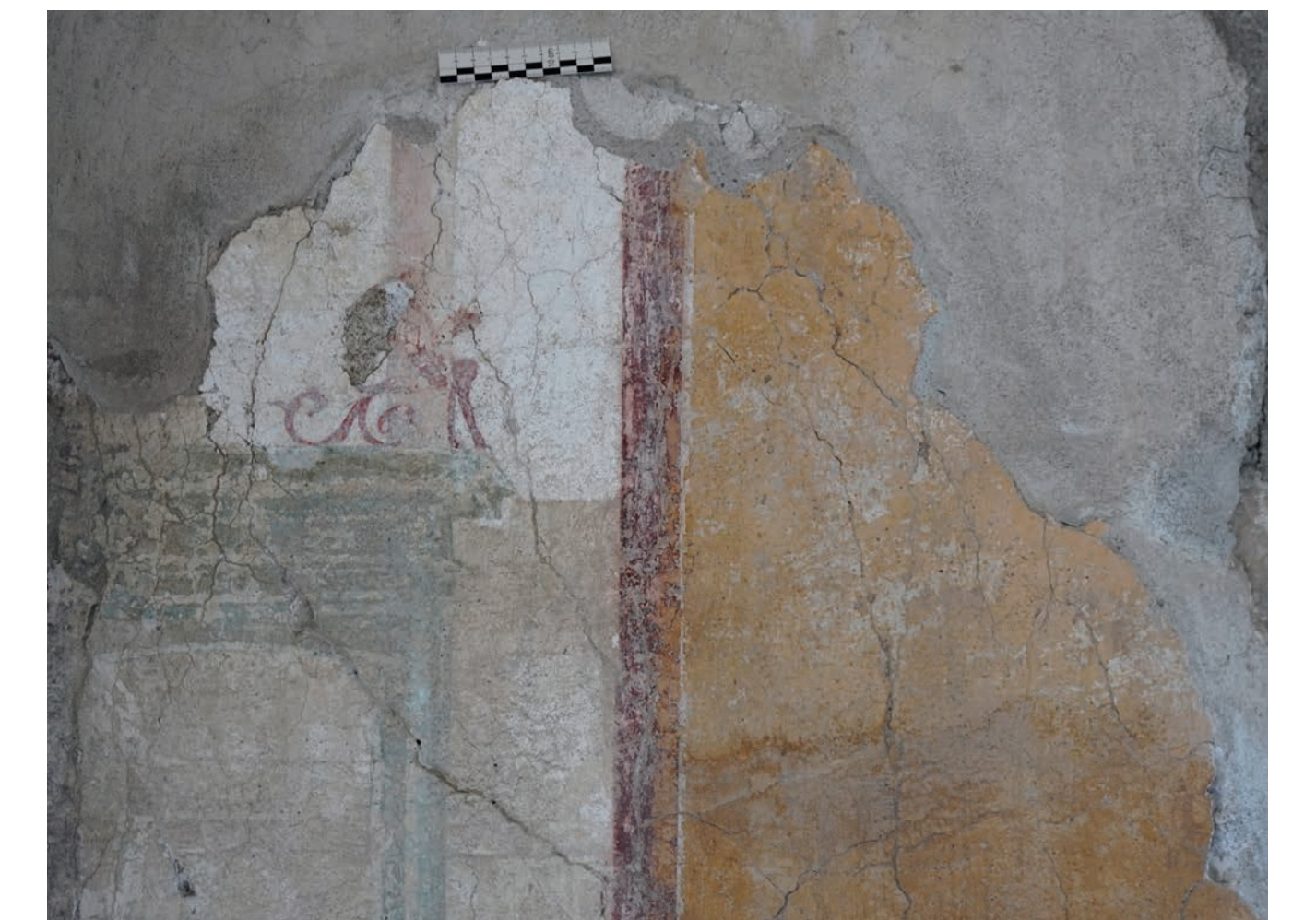
Zwischenzustand während der Kunststoffreduzierung
