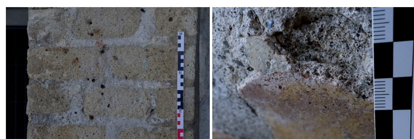
Opus quadratum Mauerwerk Putzstratigrafie
