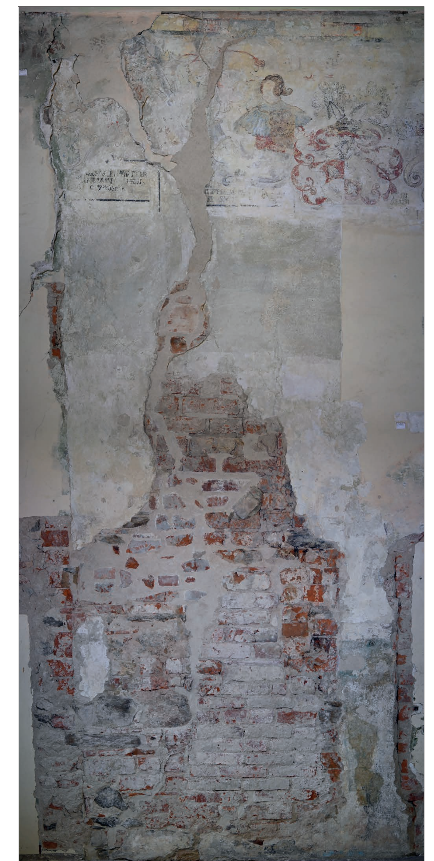
Musterfläche an der Nordwand nach Abschluss der Maßnahmen
