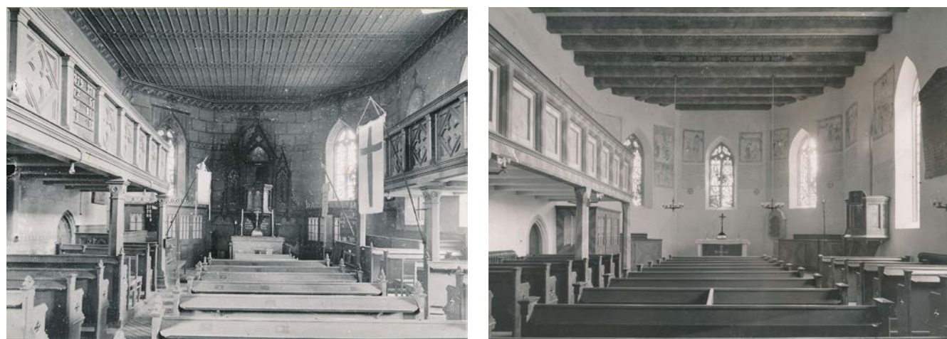
Blick in den Ostchor: historische Gestaltungsphase (links, vor 1940) und Zustand nach der Instandsetzung (rechts, 1940) Quelle: LDASA, BKD Archiv
