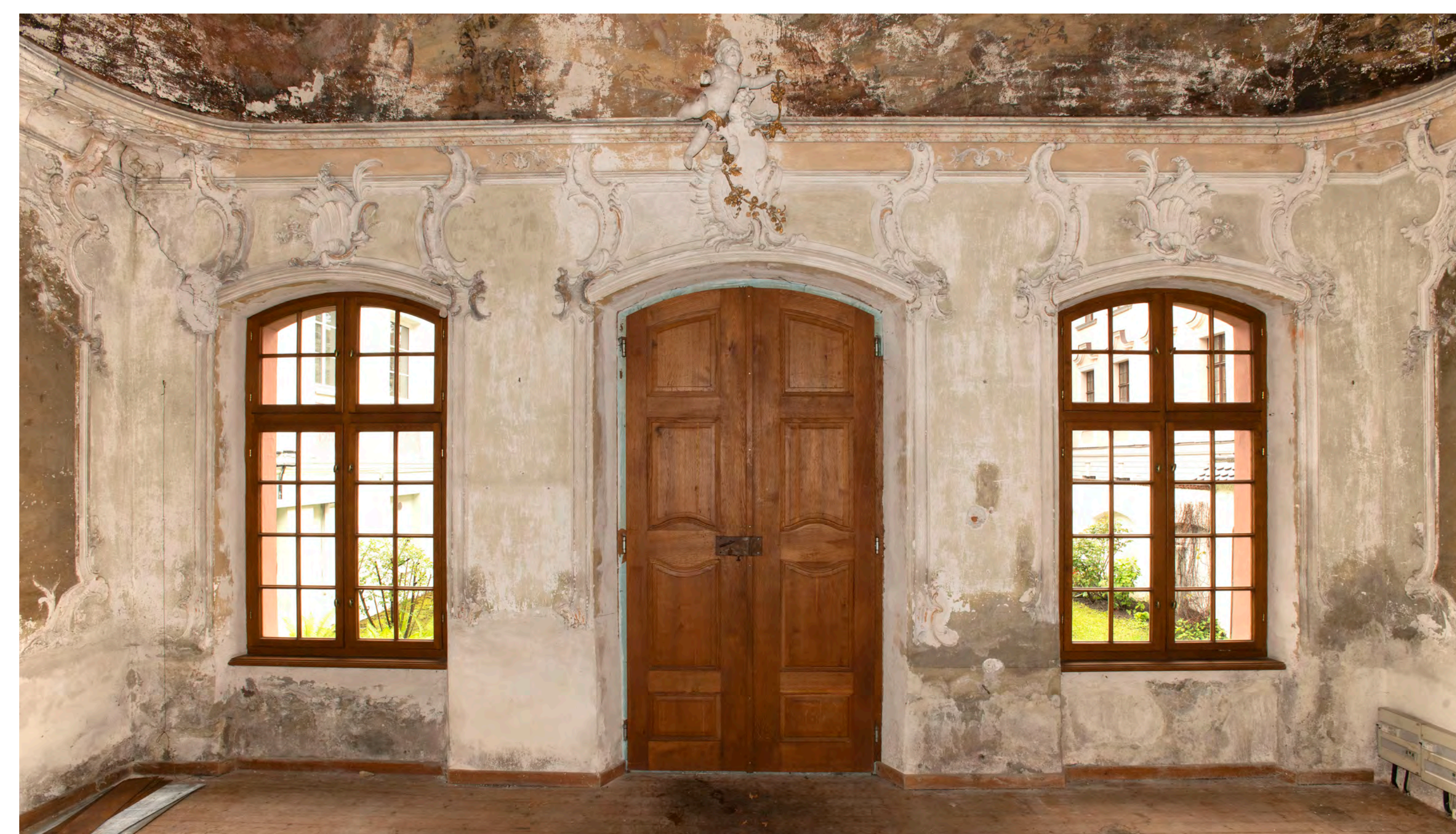
Ansicht der Nordwand
