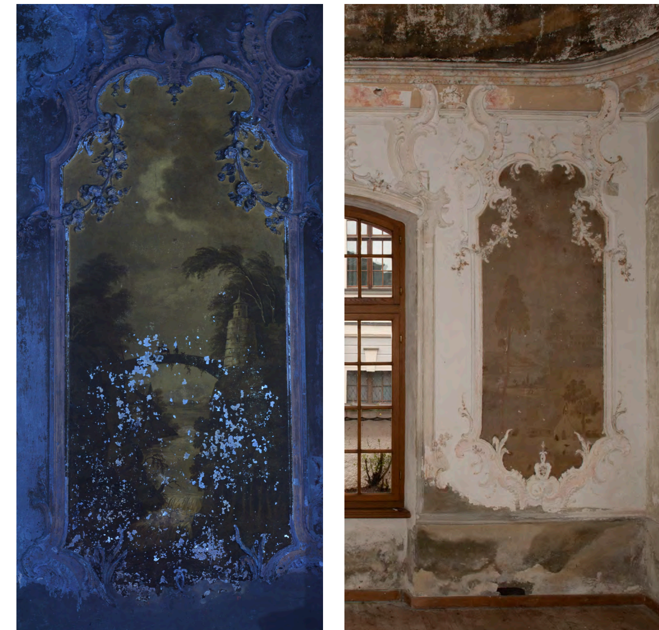
SW-WS Festigungsversuche unter UV-Lumineszenz sichtbar
