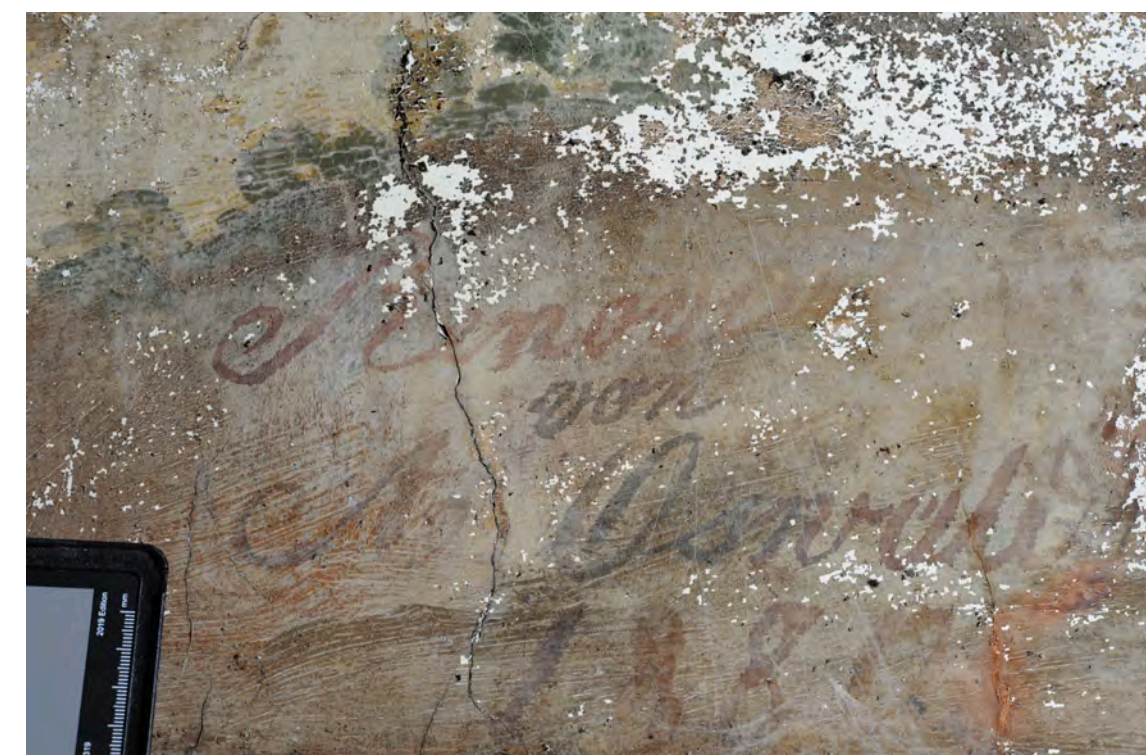
Inschrift in der Voute der Nordwand des Deckenspiegels „Renoviel[...] von A. Oswald 1880“
