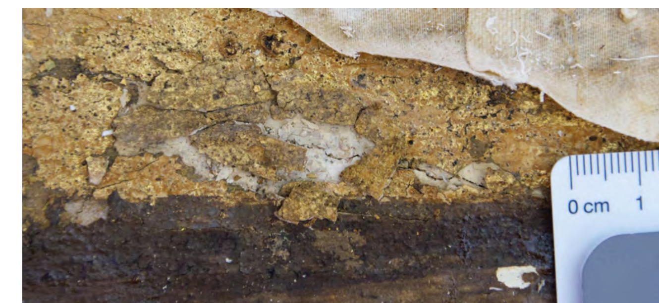
Zustand vor der adhäsiven Festigung der Farbschichtschollen
