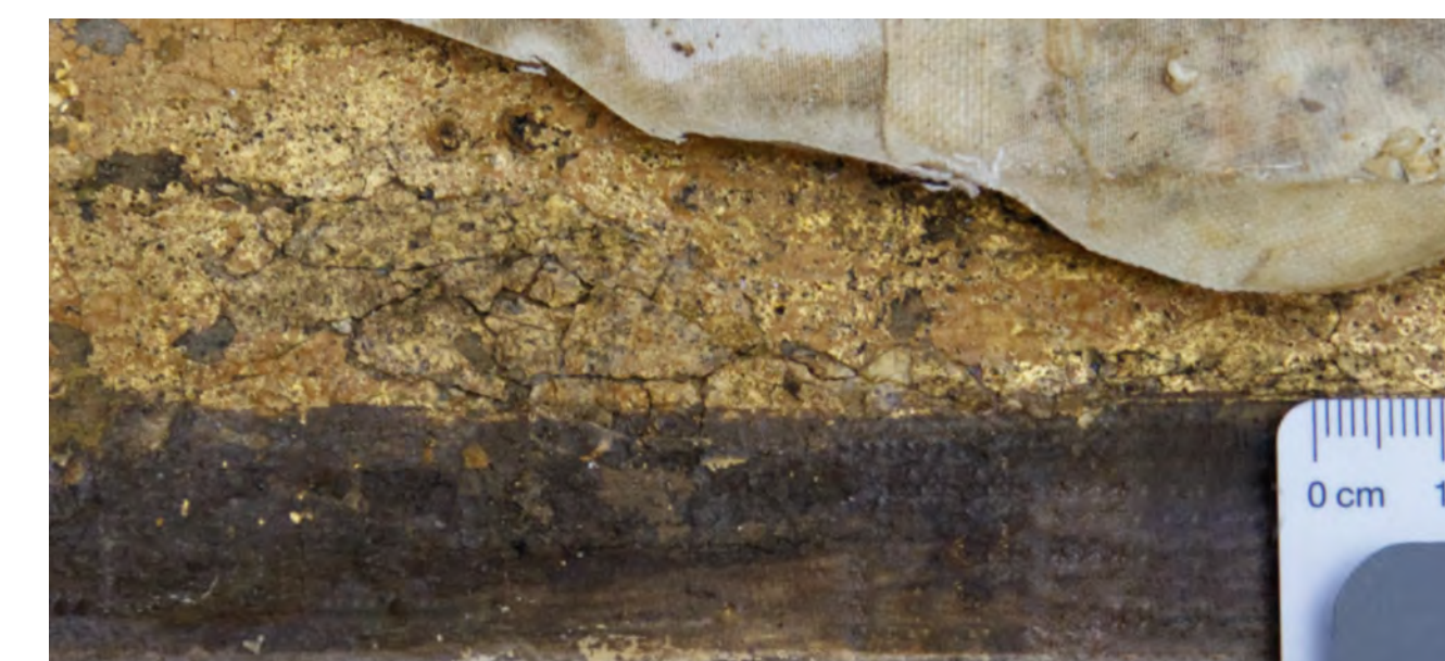
Zustand nach der adhäsiven Festigung der Farbschichtschollen
