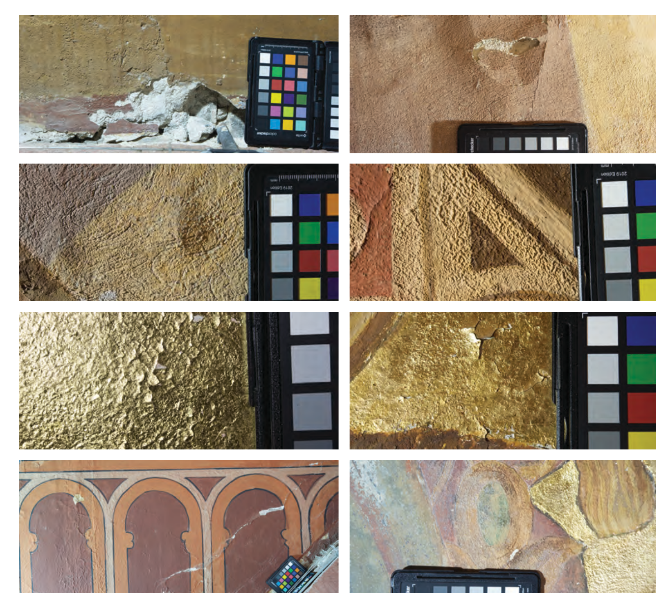
Abbröckeln, Schalen, Blasen, Runzeln, Craquelée, Schuppen, Risse, Gipsschleier, 2024/2025.
