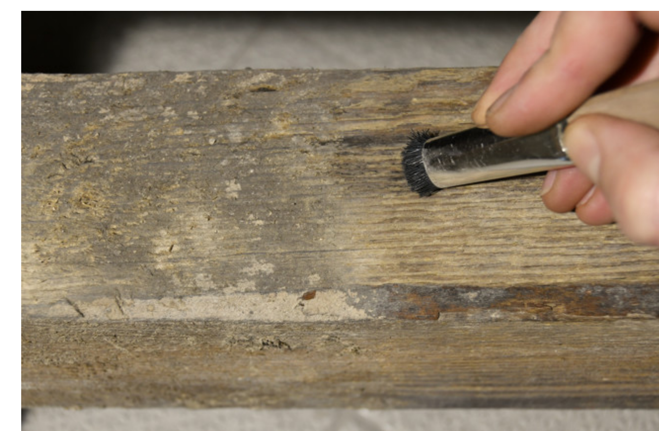
Reinigungsmaßnahmen auf dem hölzernen Bestand.
